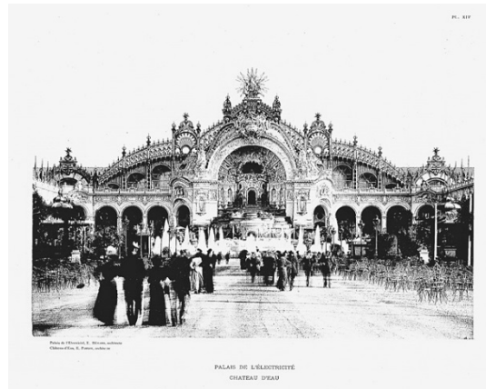
電気館と水宮噴水（1）
