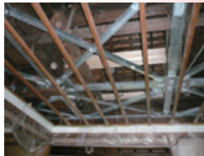
天井裏水平プレス取付
