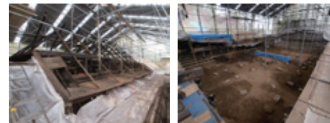
解体中（兜造り屋根の軸組）
