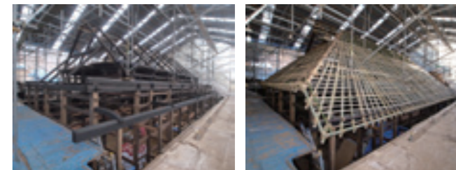
組立（入母屋屋根軸組）
