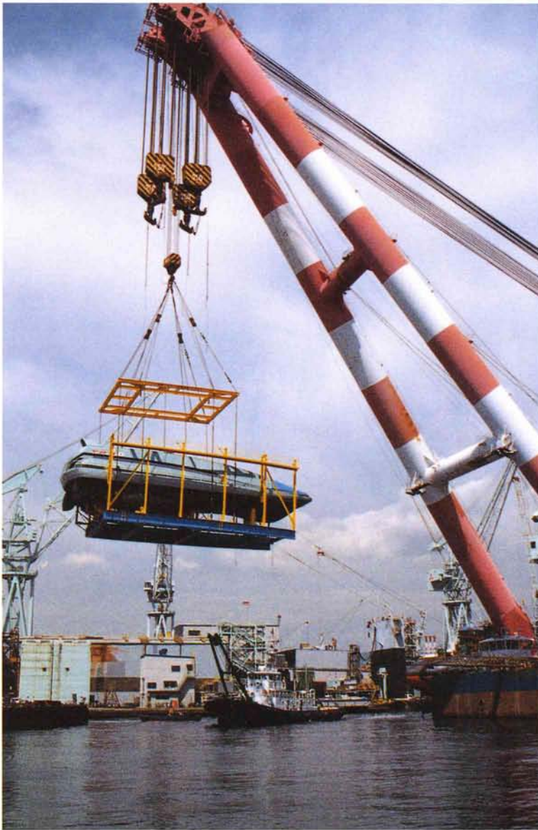
写真8.2 クレーン船を使って架台ごと「ヤマト-1」をつり上げ、海上に着水させるときの写真
