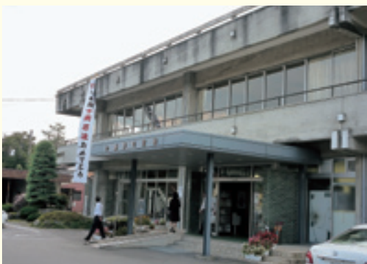
埼玉県小鹿野町役場
