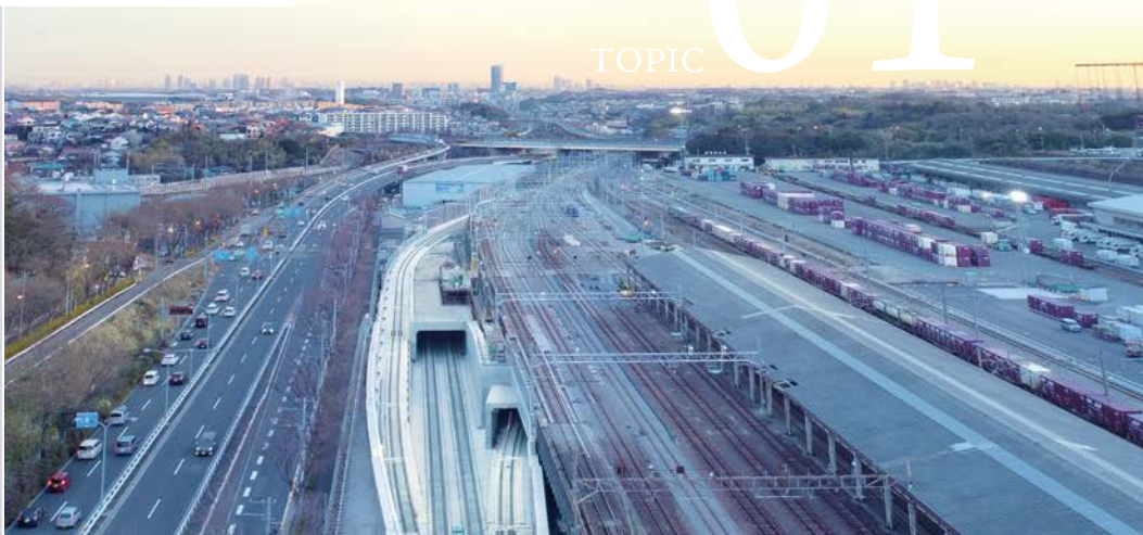
羽沢横浜国大駅付近
