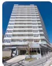
建替事業により誕生した「グレースシア茅ヶ崎」
