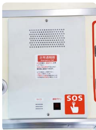
電車内に設置した非常通報器
