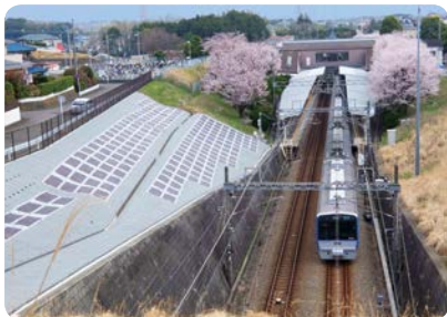
弥生台駅の薄膜型太陽光発電設備
