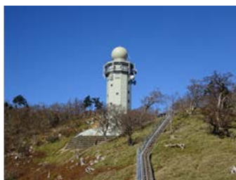
高城山レーダ雨量観測所(徳島)
