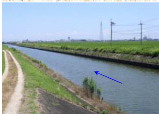
護岸・河道掘削の整備完了状況
