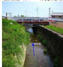
上流部の河道狭小部
