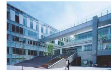
階段の上には東棟4階と高層棟4階を結ぶブリッジが設けられています
