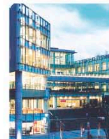
左側が東棟のコーナー部分
