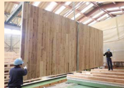
工場でのCLT生産
