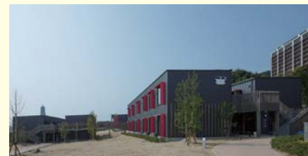
「CLTパネル工法」による宿泊施設
