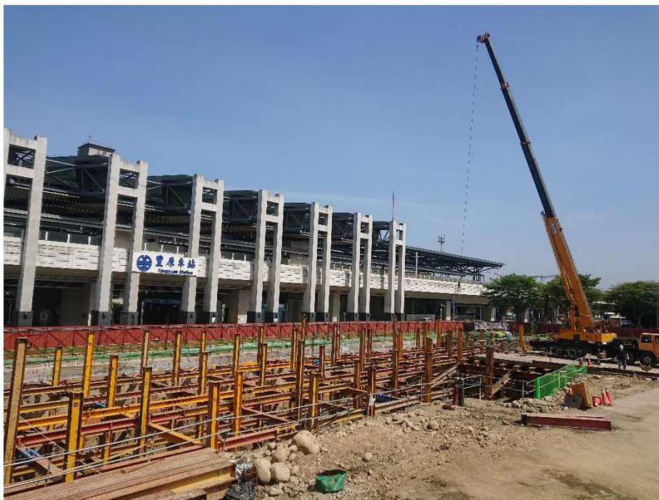
圖 21 豐原轉運中心現場施工照片
