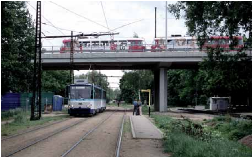
T6-vaunupari linjalla 2 matkalla Tapešu ielalle. Jūrmalas gatven sillalla porhaltaa 4-linjan T3-vaunupari Imantasta keskustaan. Oikealla satamarataa ja loitompana häämöttävät Zasulauksin risteysaseman opastimet. 8.6.2005.
