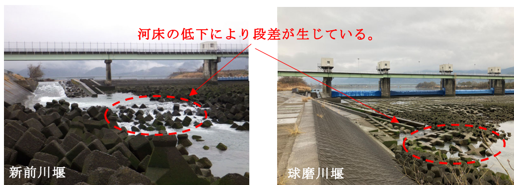
図 2.47 新前川堰・球磨川堰魚道下流の状況
