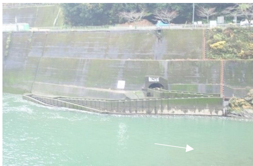
図 2.45 瀬戸石ダムの魚道
