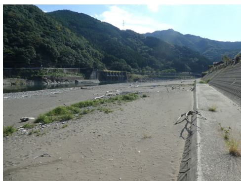
図 2.16 河道内の土砂堆積状況
