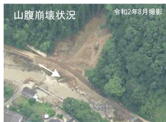
図 2.15 令和2年7月豪雨による 支川 お 小川の山腹崩壊
