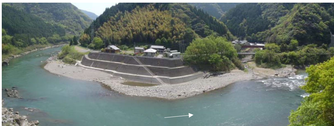
図 1.54 あまつき 天月地区完成後の状況(芦北町)
