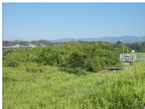
図 2.17 河道内樹木の繁茂状況
