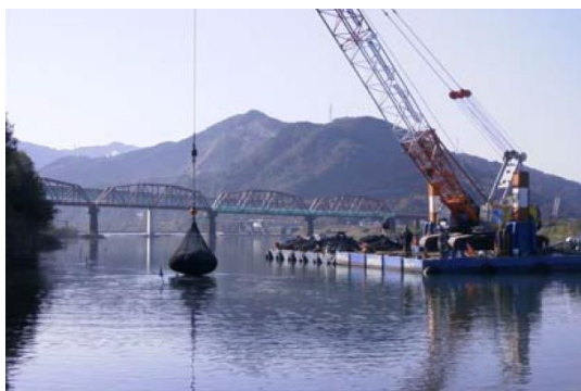
図 1.56 萩原地区の深掘れ対策状況（八代市）
