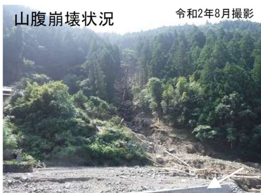
図 2.14 令和2年7月豪雨による 支川 かわうち 川内川の山腹崩壊
