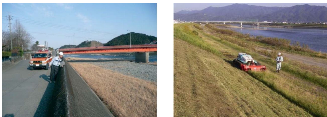
図 5.27 河川巡視及び除草状況
