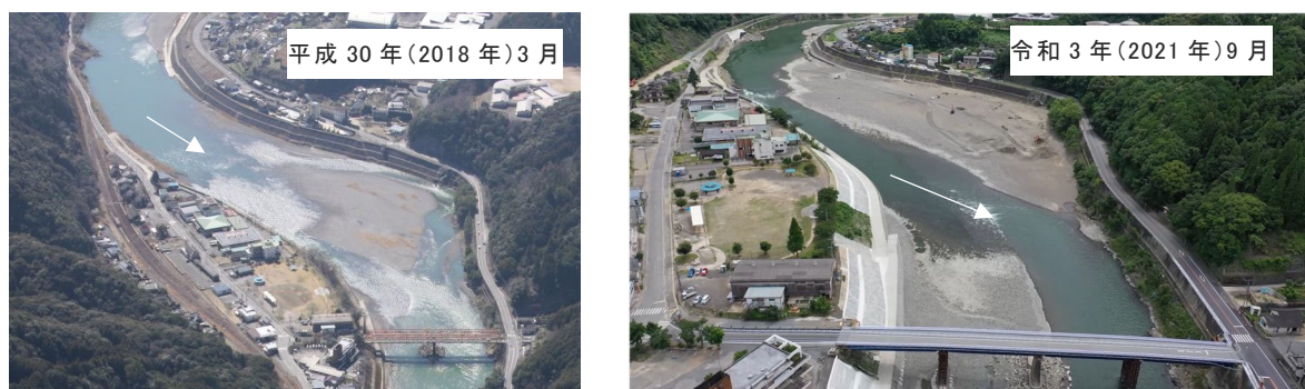
図 2.43 土砂堆積状況 (坂本支所付近)
