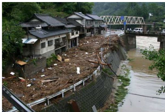
漆川内川浸水後の状況(芦北町)
