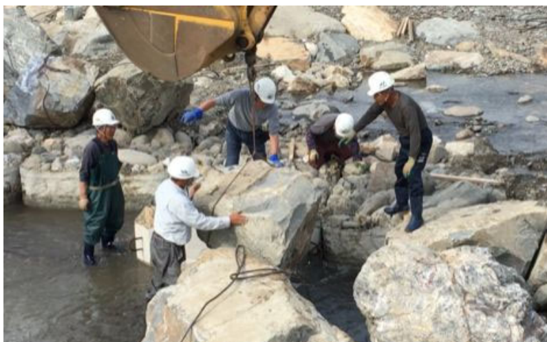
図 6.13 石工の巨石設置の技術（八の字堰の施工状況）
