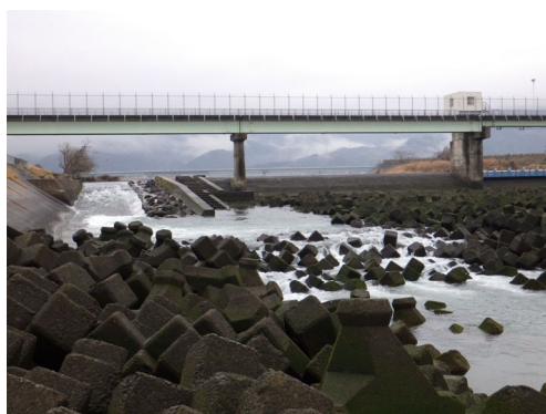
図 5.15 新前川堰の魚道
