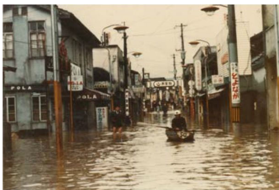
浸水状況(人吉市)
