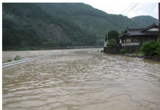
合志野地区の道路冠水状況(八代市坂本町)
