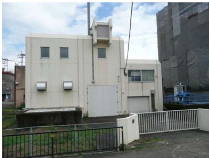
図 1.55 九日町排水機場(昭和 55 年(1980 年)3 月完成)
