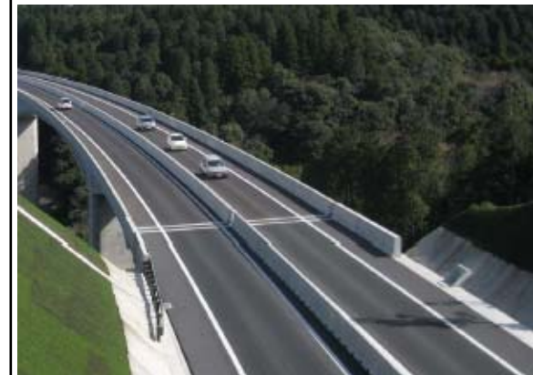
▲ 中央分離帯設置状況(東九州道)
