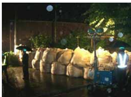
平成18年5月22日応急対策施工状況 (唐津市北波多) 岩石の崩落の可能性があるため、国道を片側規制し、大型土嚢を設置した。
