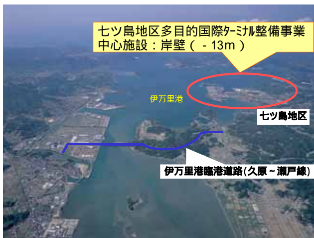
七ツ島地区の岸壁整備状況
