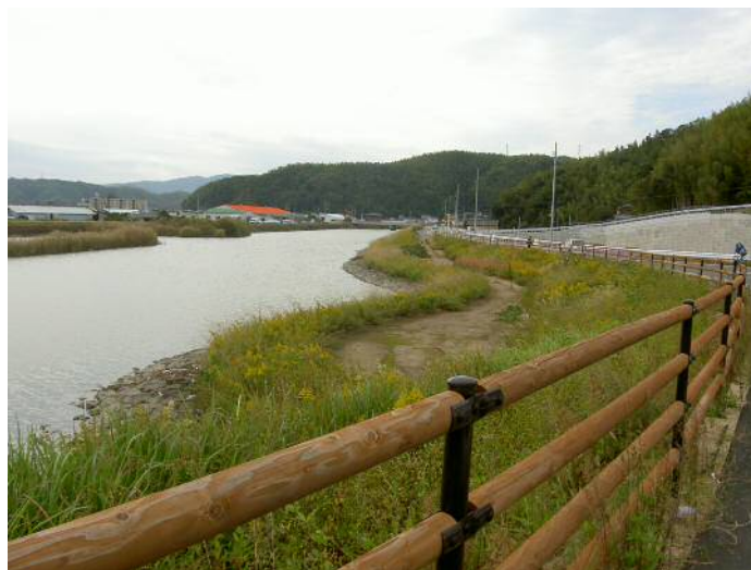
写真 2.4 立江川左岸の緩傾斜護岸（小田橋上流部）
