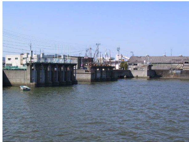
写真 4.1 既設の田野川樋門
