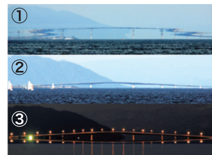
写真6-6-1 蜃気楼の比較1 ①琵琶湖大橋の上位蜃気楼 ②通常風景 ③琵琶湖大橋の夜の低位蜃気楼 ※写真はすべて大津市湖岸なぎさ公園おまつり広場より撮影
