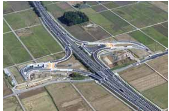
図-8 蒲生スマートインター施工状況
