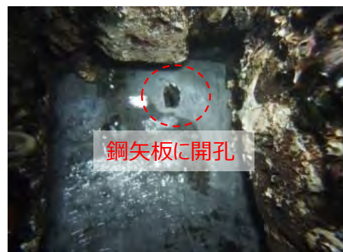
本體工（鋼矢板）の損傷状況
