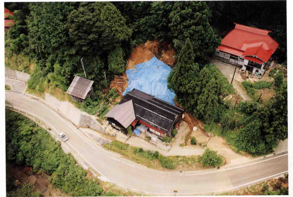
裏山で地すべりが発生し、人家の壁を破損(東頸城郡安塚町武能)
