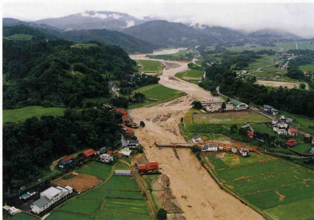
新井市下濁川地内。落橋した市道学校橋
