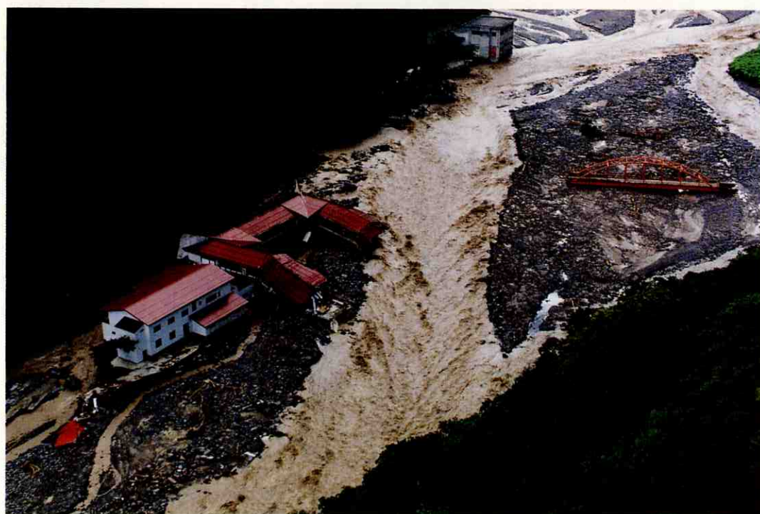
河道が埋まりホテルの敷地まで氾濫した。橋梁はそのままの位置で土砂に埋まった(糸魚川市平岩)
