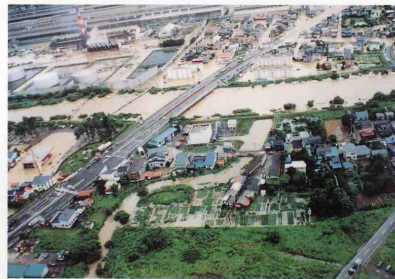
保倉川や戸野目川などの関川支川でも溢水により住宅や工場などに浸水被害が及んだ(上越市内)
