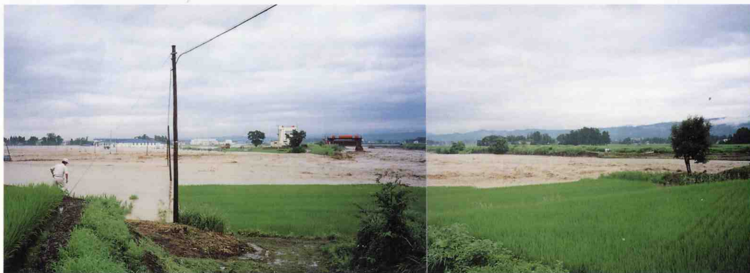
破堤し氾濫している状況(新井市月岡)
