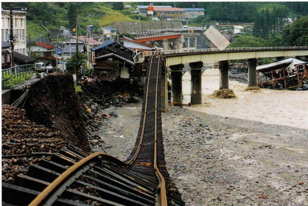
流失したJR大糸線、堤防、宅地(糸魚川市平岩)
