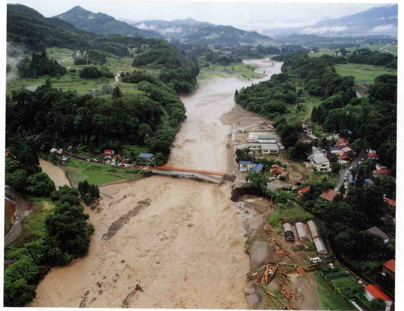
新井市猿橋地区で破堤
