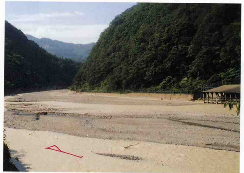
河道の土砂の異常堆積によりJR大糸線の軌道が埋没 (糸魚川市小滝)
