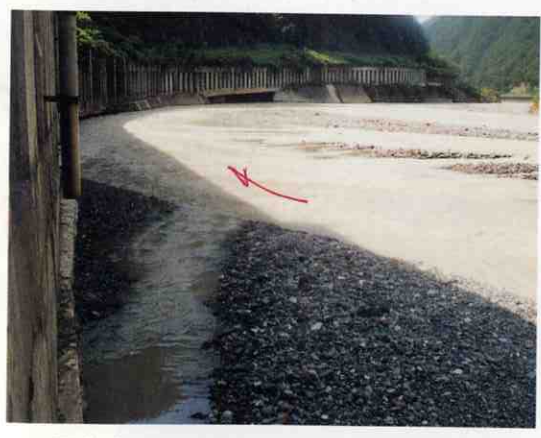
平成7年8月1日の同一箇所土砂の異常堆積状況
