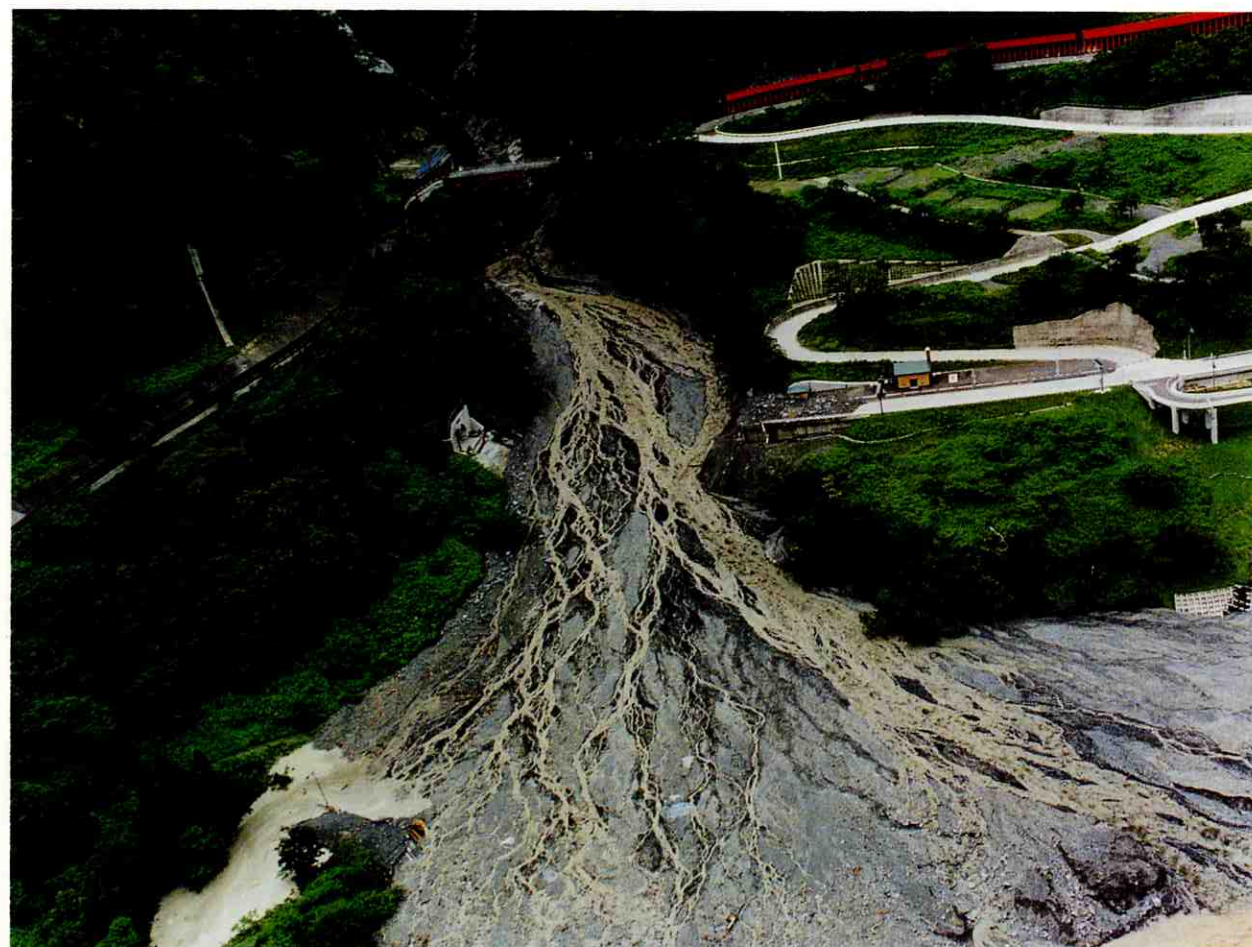
土石流により流失した国道148号の新国堺橋(糸魚川市蒲原)
