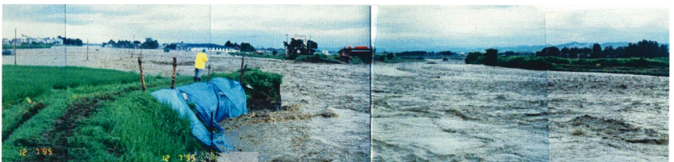
月岡の破堤状況(7月12日)
