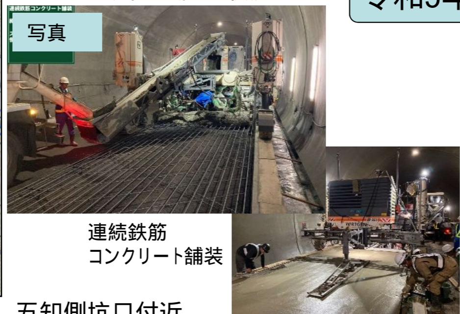
トンネル坑内の施工状況
