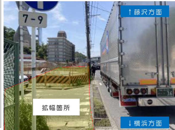
危険な現道状況
