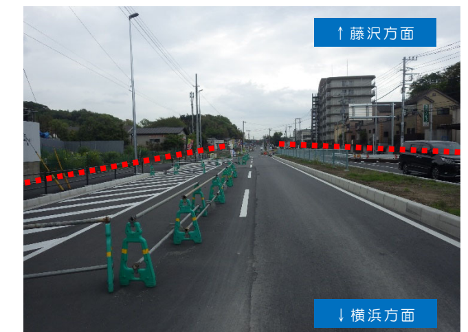
整備済み箇所の現道状況
