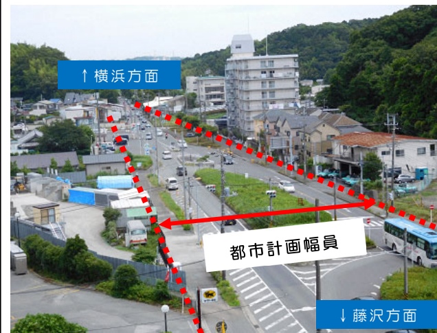
未整備箇所の現道状況
