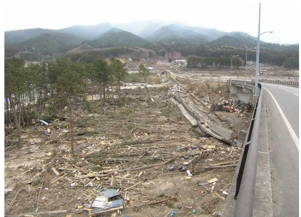
浦の浜地区防潮堤、海岸防災林（山田町）
