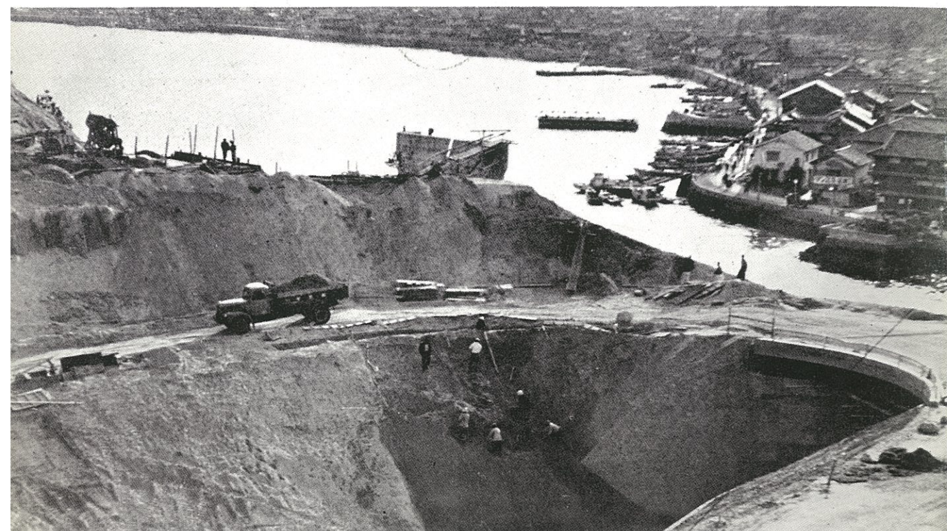
ループ式道路の土工工事 (36.2)
