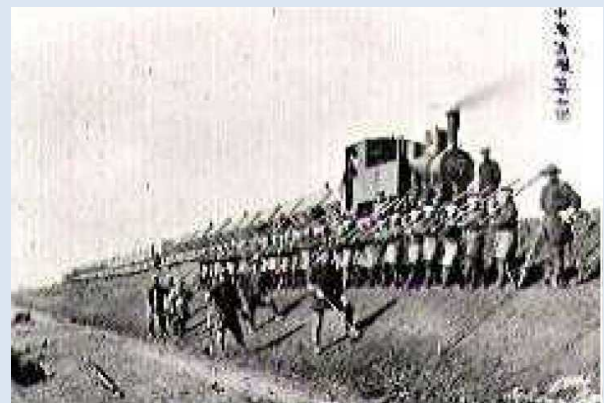
築堤の様子 大正中期頃 利根川100年史より
