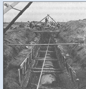
昭和初期における水道管埋設工事 の様子(松戸市)
