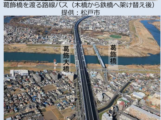
現在の葛飾橋周辺 提供：東日本高速道路（株）
