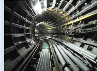
二次覆工（仕上げ）前の下水道管
