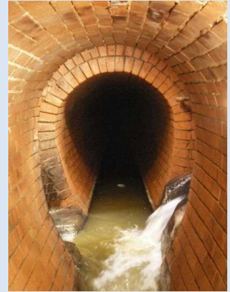
現在も一部が機能している日本で最初の近代下水（神田下水） （出典：公益社団法人土木学会 選奨土木遺産）
