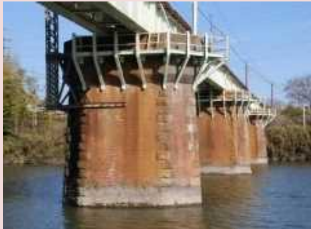
JR成田線我孫子支線の橋脚部
