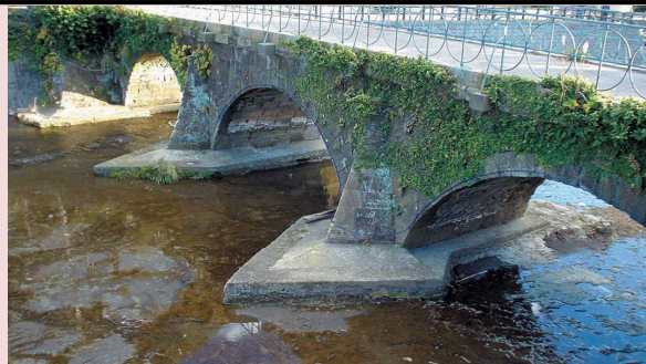
上流側の橋脚に設置された水切り 出典：土木学会誌（2006年2月号）
