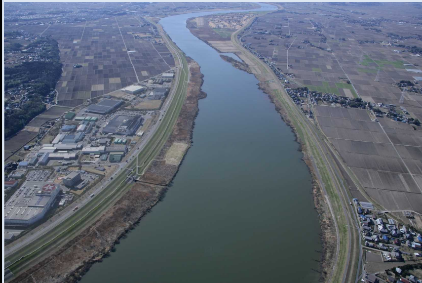
矢口スーパー堤防と工業団地（中央左側が矢口スーパー堤防） 平成20年撮影
