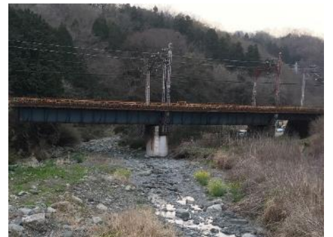
第1四十八瀬川橋梁 （渋沢～新松田駅間）
