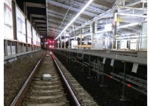
ホームドア設置に先駆けたホーム補強工事（本厚木駅）
