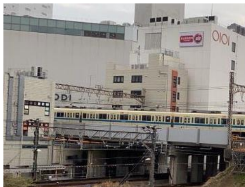
横浜線跨線橋（町田～相模大野駅間）
