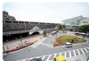
現在の経堂駅(駅前広場・駅ビル)
