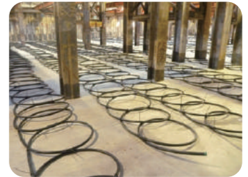
地中熱ヒートポンプを利用し、熱源を取り入れるコイルの敷設状況
