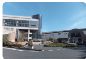
現在の狛江駅(駅前広場・駅ビル)
