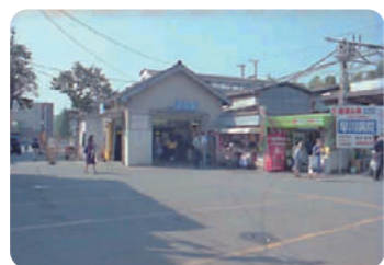
工事着手前の狛江駅
