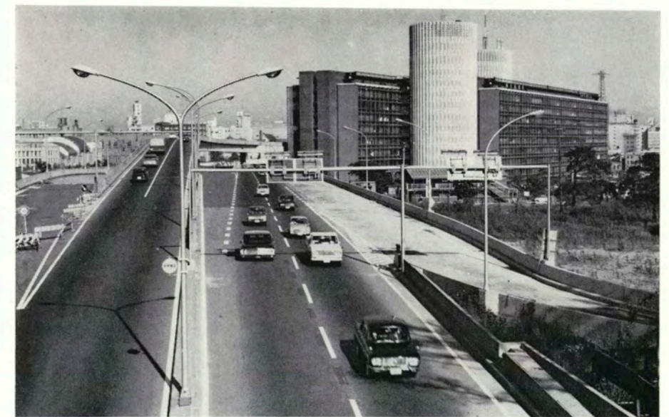
高速道路から見た全景 General view from the highway
