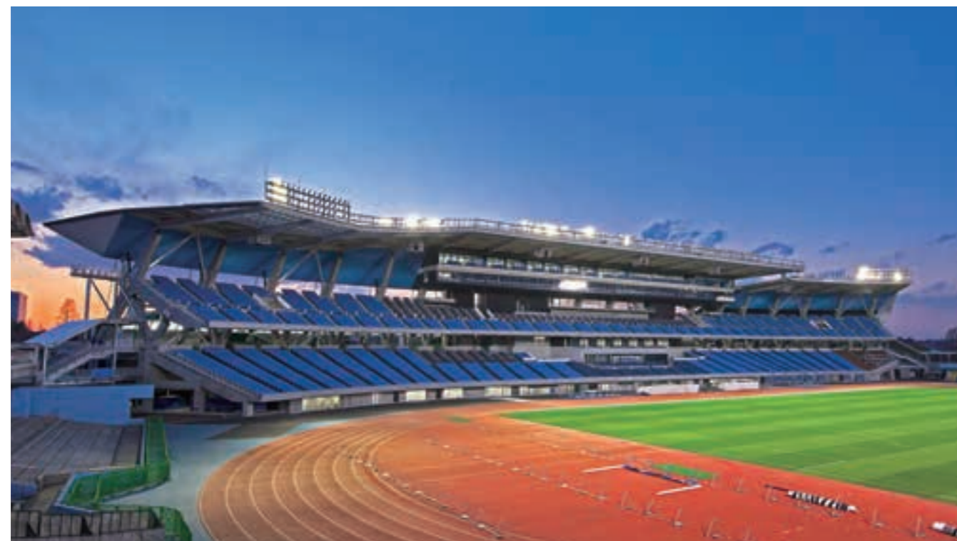
今後工事の計画があるサイド・バックスタンドよりメインスタンドをみる。座席から軒裏までカラースキームを統一して演出効果を高めている View from Side Back Stand (to be completed later) to Main Stand. Total integrated color scheme from seats to soffits heightens dramatic effect.
