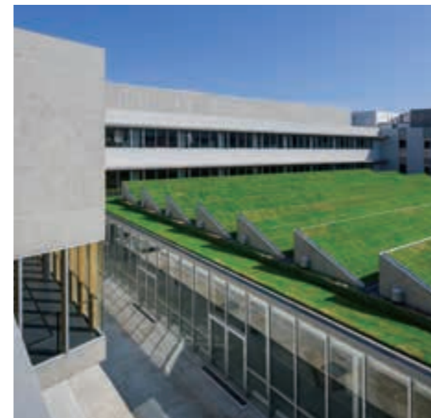
「ものづくりスクエア」上部の屋上緑化。のこぎり型の屋根から自然採光・通風ができる Roof Garden on "Monozukuri Square" roof Natural Lighting and Ventilation from Saw Tooth Roof
