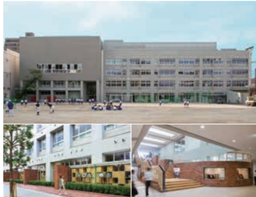
上/少人数化などのクラス編成の変化に対応するための普通教室の中間柱とライトシェルフを組み合わせたサスティナブルな外観 top: "Sustainable" frontage showing the middle column and light shelf structures that will allow accommodation to future reduction of class sizes.
