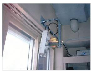
図5 稚内商工高校に向けて屋内に設置した無線 LAN平面アンテナ(稚内東中学校)
