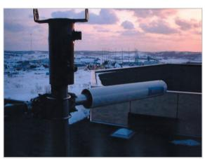
図4 稚内大谷高校に向けて屋外に設置した無線 LANハ木アンテナ(稚内北星)
