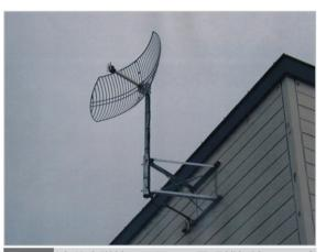
図 12 宗谷中学校に設置した長距離無線 LAN パラボラアンテナ
