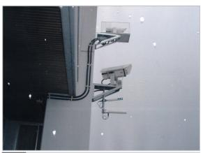
図9 稚内高校に設置した、レーザ光空間通信装置2機(稚内北星及び稚内商工高校向け)と、バックアップ回線用の無線LANアンテナ2本
