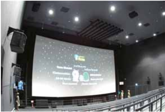
図 1.4 「愛・地球博」で展示した 22.2 マルチチャンネル音響システム (口絵参照)
