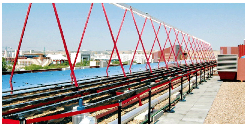
図 5-52 吸収式冷凍機の稼動に用いられるリニア・フレネル型コレクタ（Industrial Solar）
