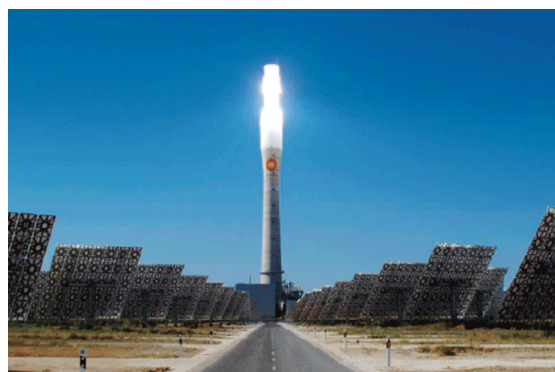
図 5-46 GEMASOLAR プラント（タワー部分） 出典：SolarPACES 資料
