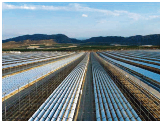
図 5-32 建設中の PE-2 プラント (スペイン)
