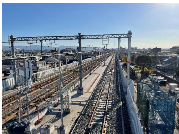
全線高架化完成間近の羽衣駅南側
