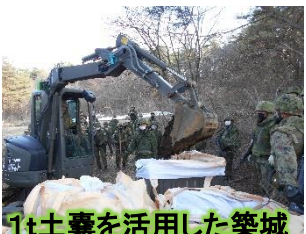
1t土嚢を活用した築城
