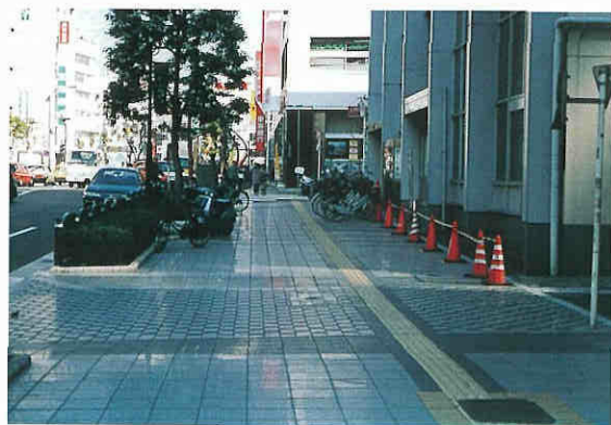
路面を改良して歩行者の歩きやすい歩道に
