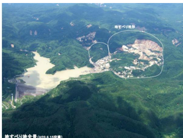
写真-6 岩手・宮城内陸地震による荒砥沢ダム周辺の大規模な土砂移動（地すべり）
