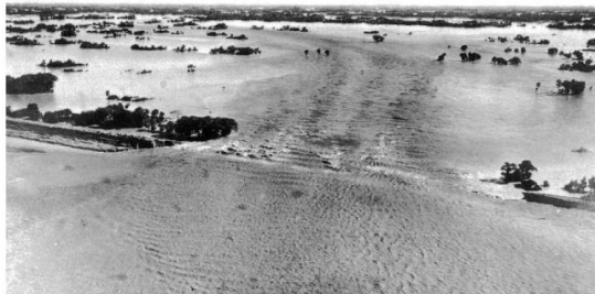
写真-1 利根川右岸埼玉県東村での越水・決壊（国土交通省関東地方整備局利根川上流河川事務所）
