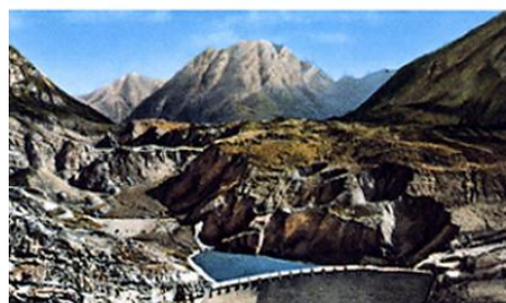
写真-7 被災後のバイオントダムの貯水池と大規模土砂移動の痕跡
