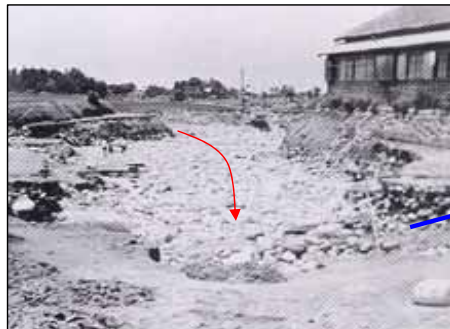
氾濫流による洗堀状況（荻生地先）
