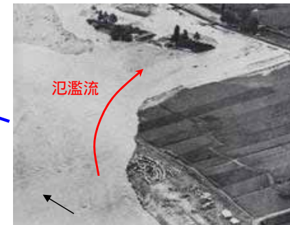
洪水流による破堤状況（福島地先）
