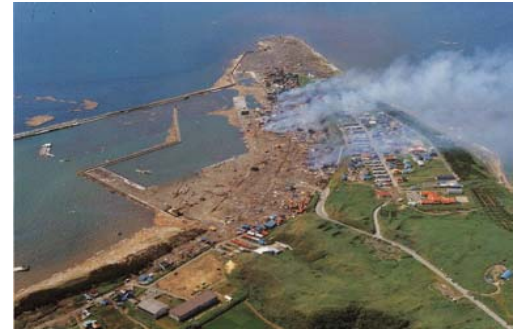
◆津波による被害 平成5年北海道南西沖地震津波による被害(北海道奥尻町)
