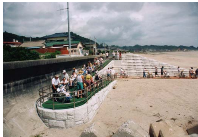
スロープの設置(福島県いわき市)
