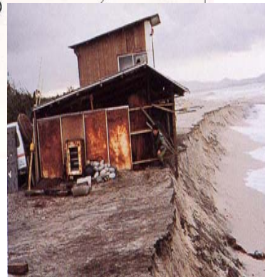
◆侵食による被害 冬季風浪による海岸侵食(鳥取県米子市)
