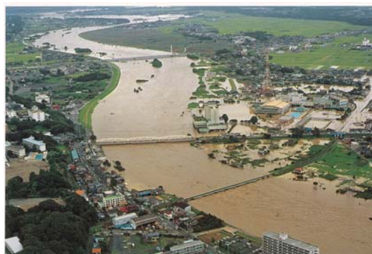
▲平成 10 年洪水 那珂川の氾濫（水戸市）
