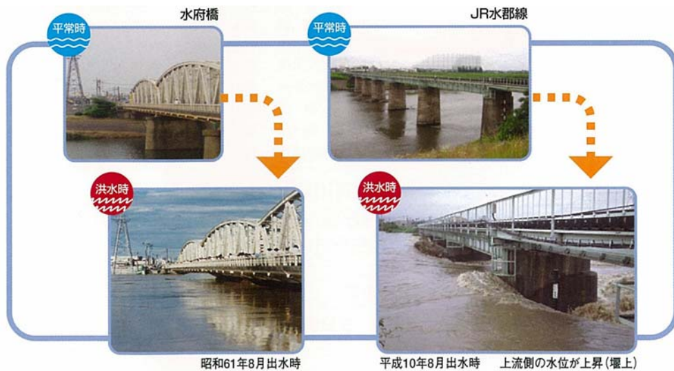
図 4-7 洪水時の水府橋及び JR 水郡線那珂川橋梁の状況
