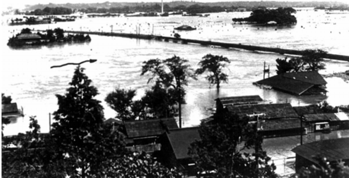
▲昭和 22 年 9 月洪水の様子（水郡線鉄橋付近）
