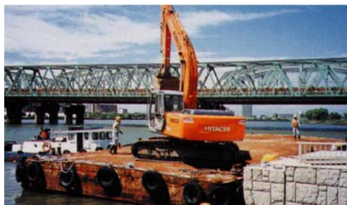
リバーステーションからの重機搬入 （川口リバーステーション）
