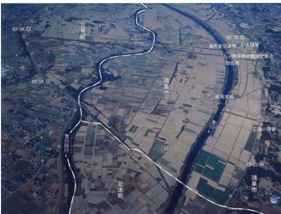
写真 8-6 御成橋付近（61.0k 付近）
