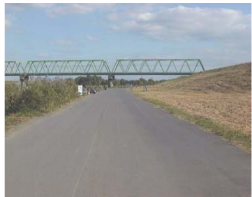
写真 9-10 緊急用河川敷道路（JR 武蔵野線付近）
