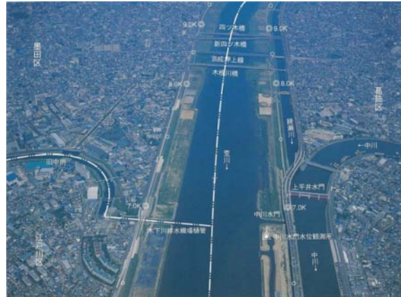
写真 8-8 京成押上線下流（7.0k 付近）
