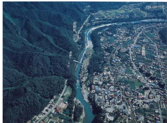
写真 8-3 長瀬（109.0k 付近）
