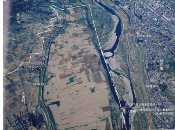
写真 8-5 久下橋（74.0k 付近）
