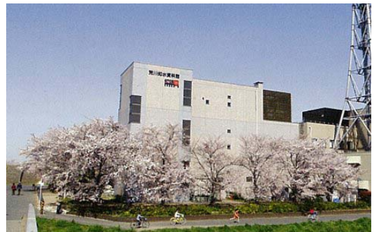
写真 9-23 荒川知水資料館
