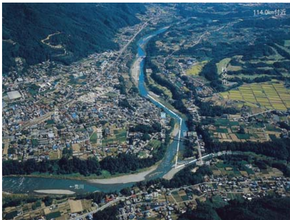
写真 8-2 赤平川合流部（114.0k 付近）
