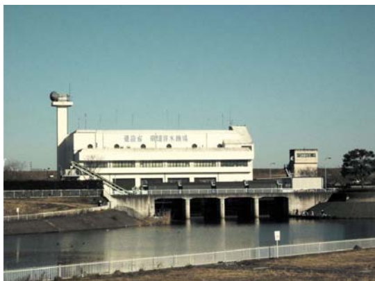
写真 4-13 南畑排水機場
