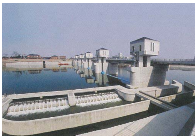
写真 5-4 六堰頭首工と流水改善水路（手前）
