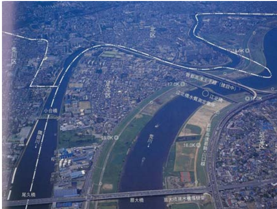
写真 8-9 扇大橋（15.0k 付近）
