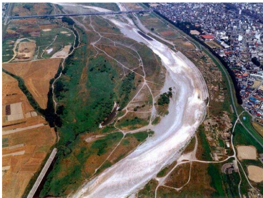
写真 5-5 熊谷付近の瀬切れの状況 (平成 4 年)
