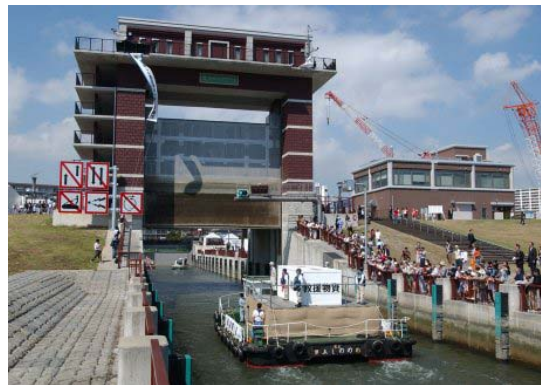
写真 7-6 荒川ロックゲート
