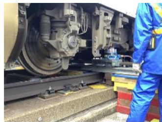
復旧作業の様子
