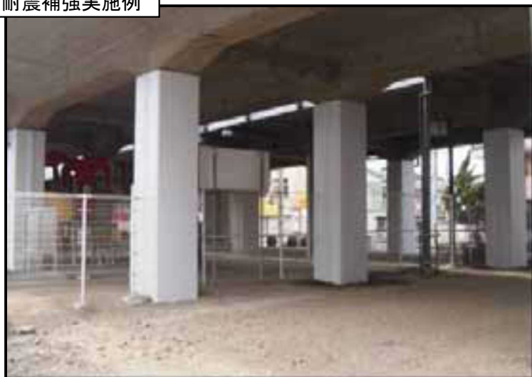
耐震補強実施例
