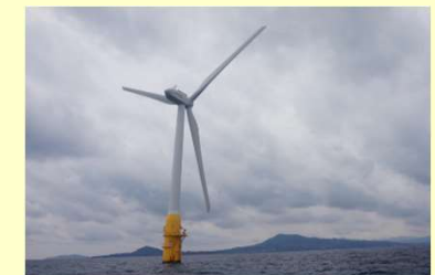
福江島の沖合で運転中の 浮体式洋上風力発電所
