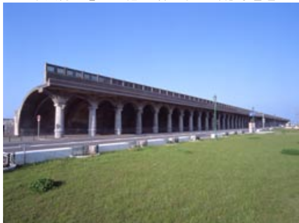
北海道稚内市/稚内港北防波堤ドーム
