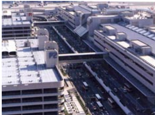
東京都大田区／羽田空港
