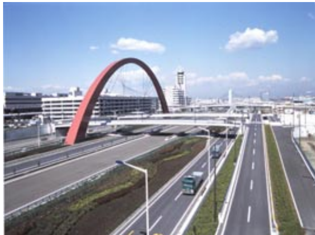
東京都大田区／羽田空港
