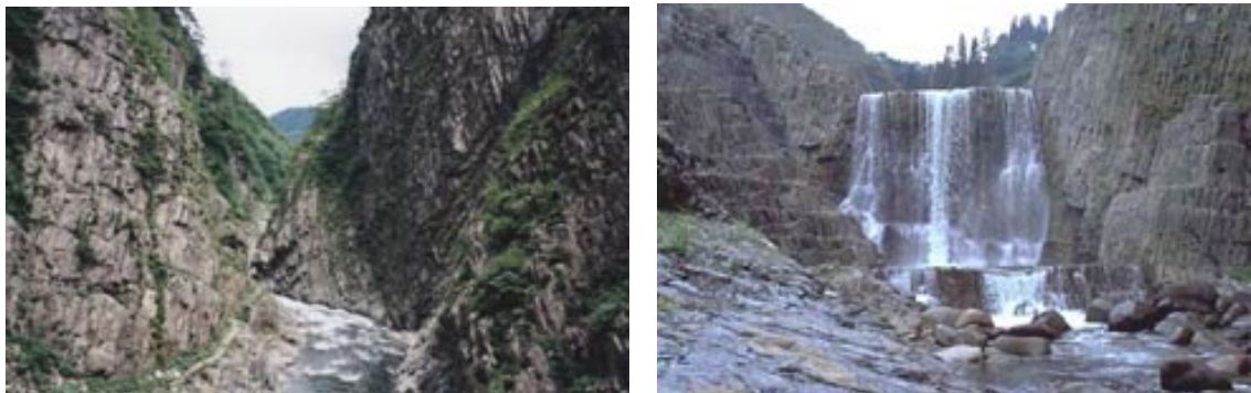
新潟県中魚沼郡中里村／清津峡、七ツ釜下流砂防えん堤
