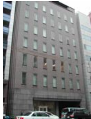
八木通商北浜ビル
