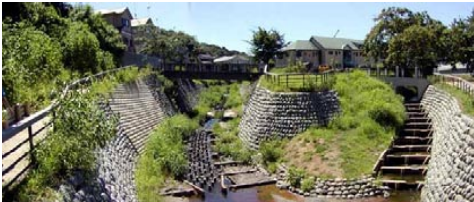
杉沢堰上流部の低水路及び護岸天端の植生回復状況
