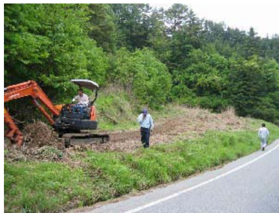
重機による、農地への復旧作業。
