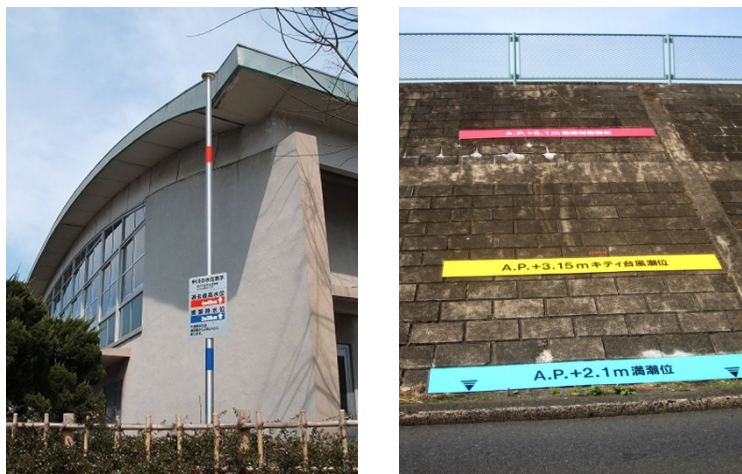
図 47 設置された水位表示ポール・水位表示板 (青の表示は満潮時の水位、赤の数字は過去最高水位)
