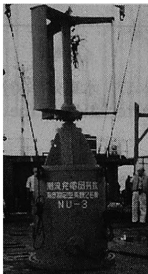
図 5.1.3 日本大学の実験水車（ダリウス型、1986～1988年） （出典：木方靖二、塩野光弘、1992）
