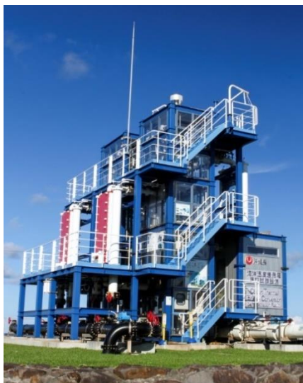
図 6.2.5 沖縄久米島実証試験設備 (出典：沖縄県海洋温度差発電実証設備ウェブサイト)
