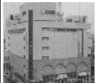
▲JR松江駅前に移転オープンした松江店 (平成10年4月)
