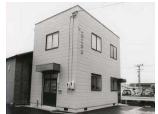
▲新築移転した一畑工務店 (平成8年7月)
