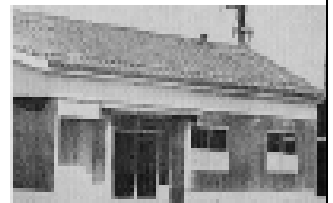
▲旧自動車整備工場の建物の一部を改装して一畑興業の新社屋を建設(昭和41年)
