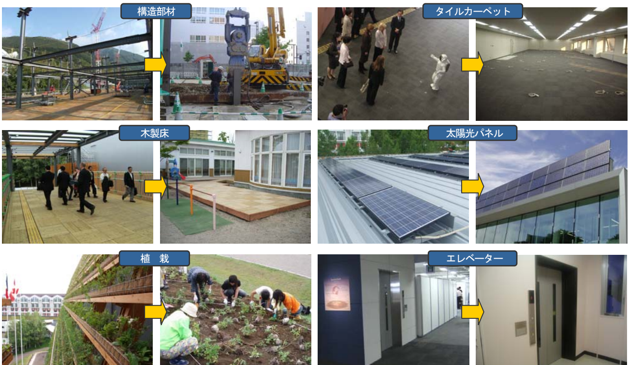
写真-4 資機材の再使用事例
