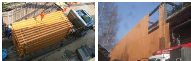
木製ルーバーのユニット化
