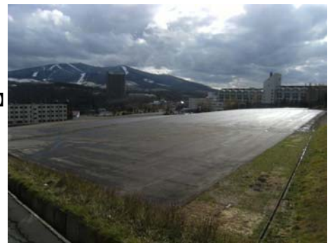
写真-2 建設から解体・復旧までの様子
