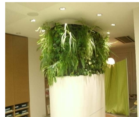
【柱に設置された壁面緑化】
