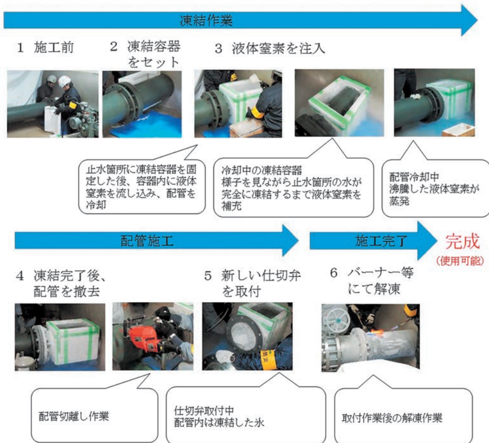
図8 配管工事（不断水凍結工法）作業手順
