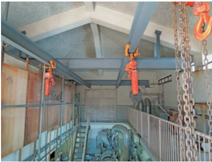
図4 H鋼架台
