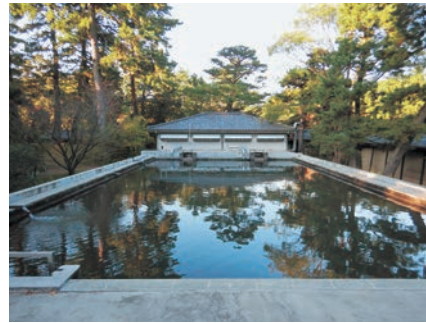
図5 貯水槽全景（奥は、ポンプ室）
