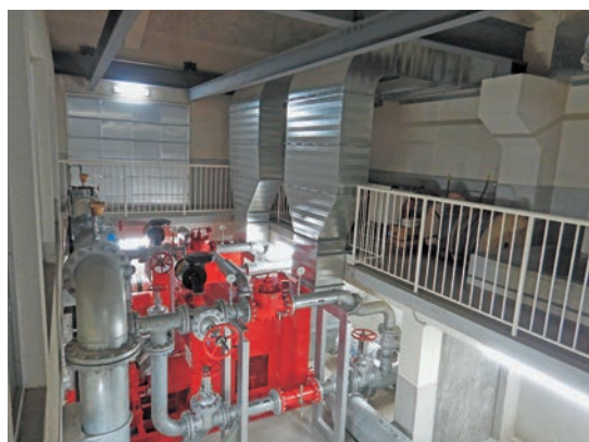
図16 完成後(東側より撮影)
