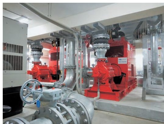
図17 完成後(北側より撮影)
